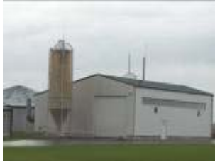
Abbildung 3.1.9 Annahmehalle, Foto: DBFZ
