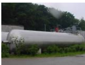
Abbildung 3.2.3 Beispiele für liegende Pfropfenstromfermenter; liegender Fermenter, zylindrisch (links), rechteckig, mit aufgesetztem Gasspeicher (rechts); Fotos: Novatech GmbH (links), DBFZ (rechts)
