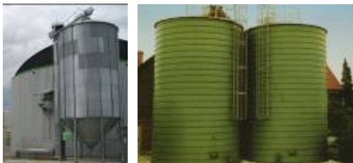
Abbildung 3.1.7 Getreidesilo mit direkter Dosierung in den Fermenter (links); Hochsilos zur Flüssigkonservierung (rechts); Fotos: DBFZ (links), Lipp (rechts)
