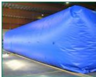
Abbildung 3.3.5 Beispiele für externe Gasspeicher; Links: Folienspeicher in Gebäude; Rechts: freistehende Doppelmembranspeicher
