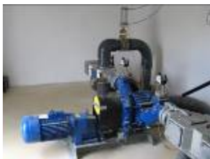
Abbildung 3.1.25 Drehkolbenpumpe; Foto: DBFZ
