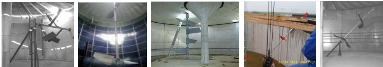
Abbildung 3.2.10 Beispiele für langsam drehende Rührwerke; von links: Seitenrührwerk mit Paddel/Haspel, zentrales Axialrührwerk mit Propeller, exzentrisches Axialrührwerk für große Behälter mit Mittelstütze, frei schwebendes Langachsührwerk
