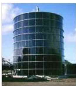
Abbildung 3.2.2 Beispiele für Fermenter in Stahlbauweise (hier: volldurchmischte, nicht einsehbar); geschraubte Platten (links), Prinzipskizze für gewickelte Blechbahnen, Prinzip (rechts); Fotos: GLS Tanks International GmbH (links), Lipp GmbH (rechts)
