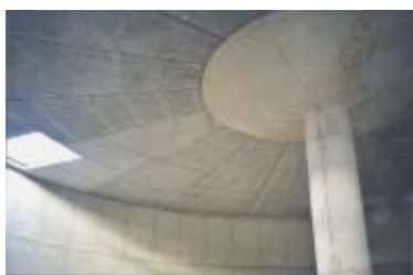
Abbildung 3.3.3 Beispiele für Behälterabdeckungen; Links: Betondecke von unten mit Pilzsäule; Rechts: Prinzipskizze zum Doppelmembranspeicher, hier als Tragluftdach; Fotos: www.sundermann.info (links), Biogashandbuch Bayern (rechts)
