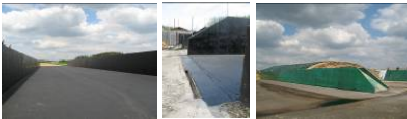
Abbildung 3.1.6 Zweiseitig eingefasstes Fahrsilo mit Asphaltdecke und Bitumenanstrich (links); Fahrsilo mit Bitumenanstrich und teilweise geöffneter Querrinne (Mitte); Fahrsilo mit Schutzanstrich (rechts); Fotos: DBFZ (alle)
