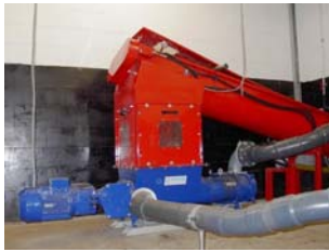
Abbildung 3.1.23 Eintrag in die Flüssigkeitsleitung; Foto: Vogelsang
