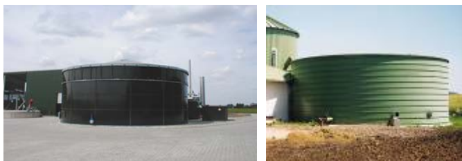
Abbildung 3.1.10 Oberirdische Güllelager aus Stahl (links: geschraubte Platten, rechts: gewickelte Blechbahnen); Fotos: Henze-Harvestore (links), Lipp (rechts)
