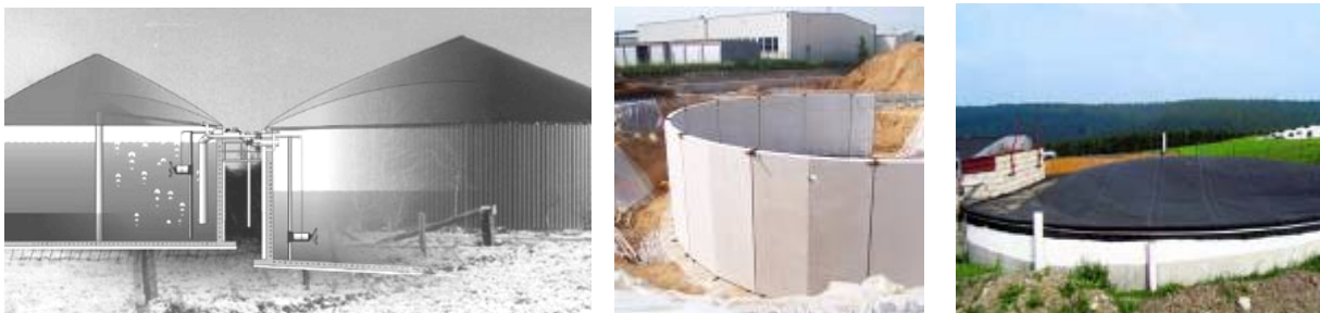
Abbildung 3.2.1 Beispiele für volldurchmischte Fermenter in Betonbauweise; Prinzipskizze des typischen Rundbehälters mit Rührwerken (links), Segmentbauweise (Mitte), abgesenkter Fermenter (rechts); Fotos: Biogas Nord GmbH (links), Drössler GmbH (Mitte), Energievision Frankenwald (rechts)
