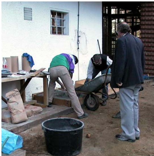
Abb. 6.14 Bearbeitung des Funktionsmodells, einbringen der zweiten Holzleichtbetonlage
