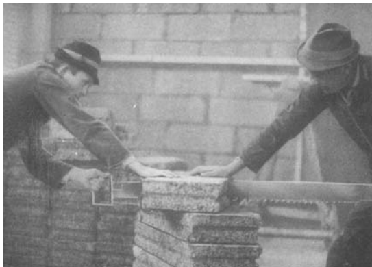
Abb. 4.8 Holzleichtbeton-Montageelemente (HB-Platten)
